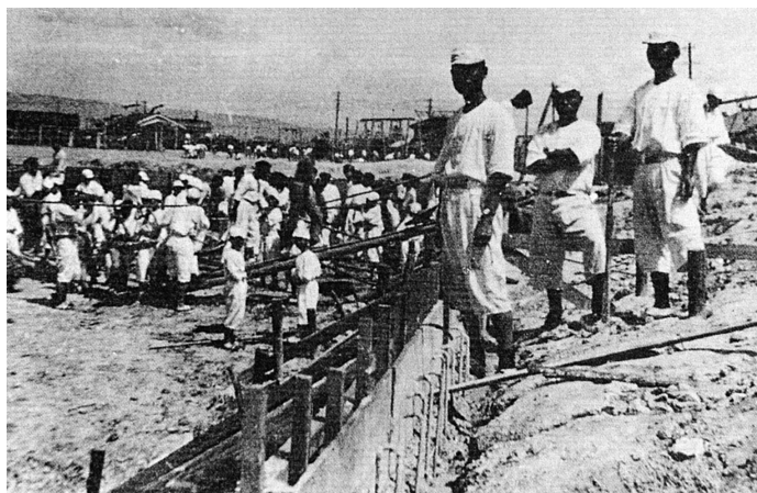
「プール建設に励む天中生」（出所：『大阪100年』より）
