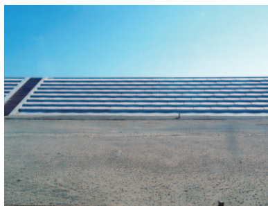
写真13. 国土交通省により荒浜地区に設置された防潮堤 (2013年10月14日)
