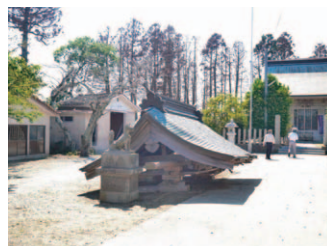
写真19-2. 津波によって流された手水場所の屋根（2012年7月4日）
