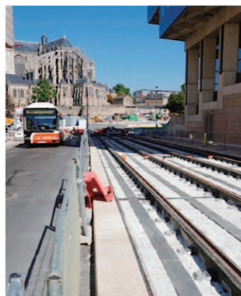
図3-20 新線建設工事
