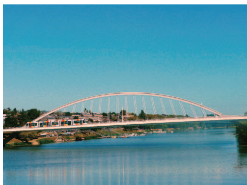
図3-6 新規に架橋された トラム、歩行者、自転車専用橋
