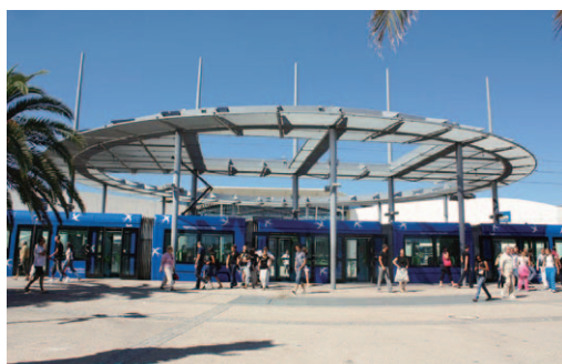
図3-34 Place de Franceの停留所大屋根
