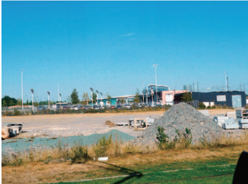
図3-7 ترام沿道の造成中の様子
