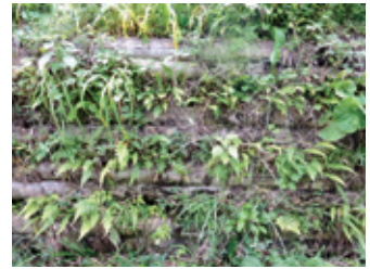
写真25. 丸太で土留めをしている農道法面畦畔植生（カラムシ，フキ，スイバなど）
