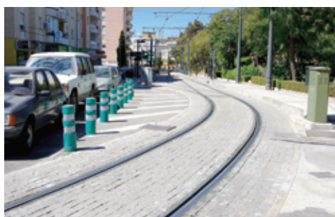
写真3-5-4 車線を減少させて設置された軌道
