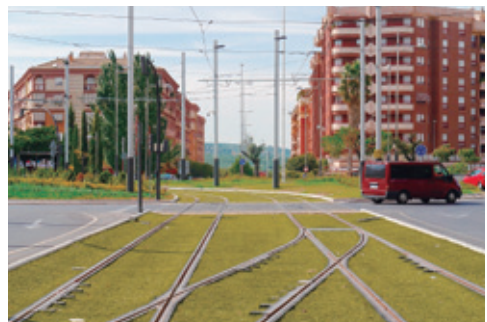
写真3-11-6 ラウンド・アバウトの中心を貫く軌道
