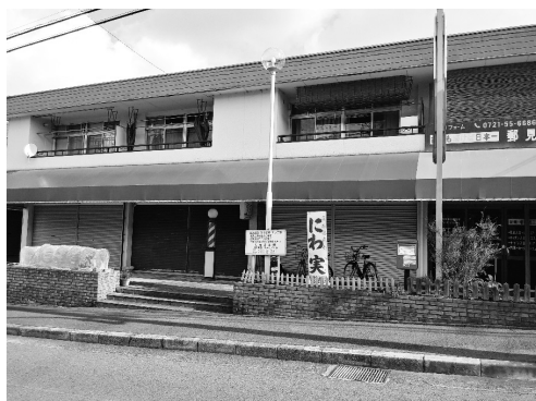
写真2 河内長野市旭ヶ丘における閉鎖された店舗の様子
