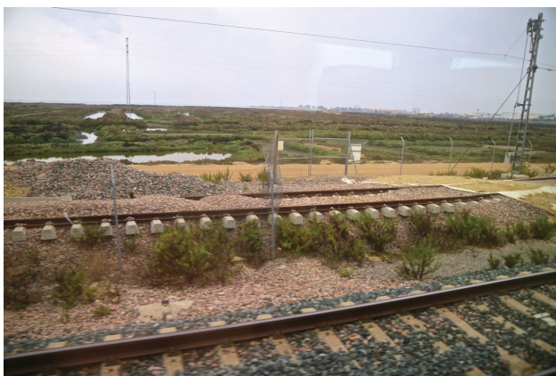
写真3-3 トラム軌道（奥）と既設鉄道線（手前）の接続部
