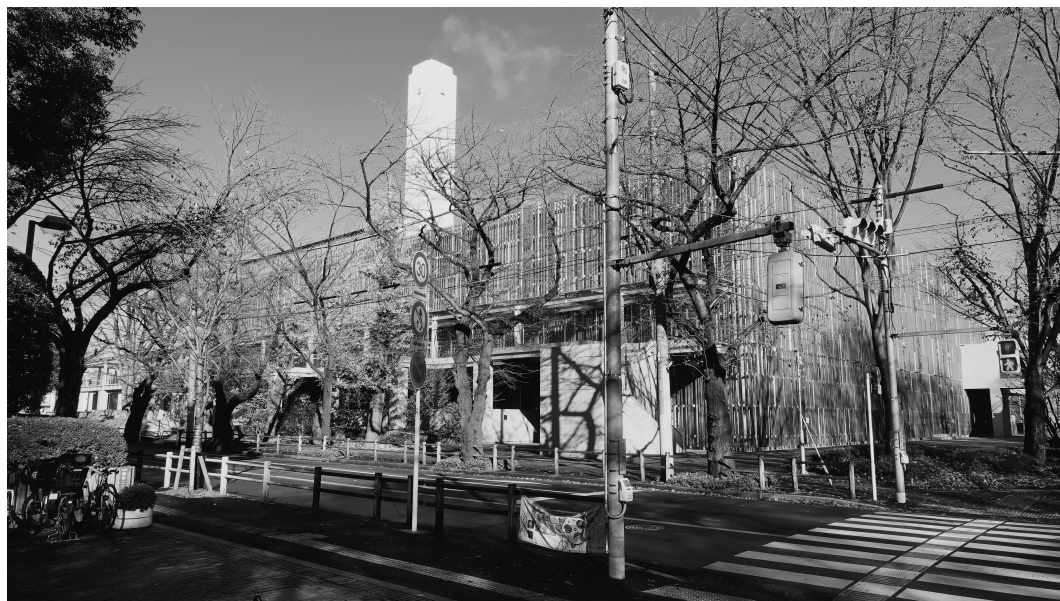
写真2 市役所，住宅団地に隣接する武蔵野クリーンセンター
