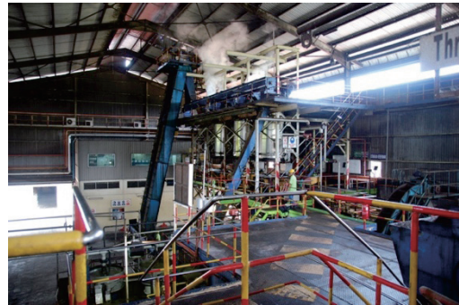
図 2.91 パームオイル製造工場
