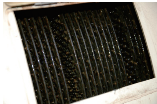
図 5.25 生物膜が付着した回転円板体
