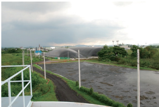
図 2.84 CPF 社の廃水処理施設
