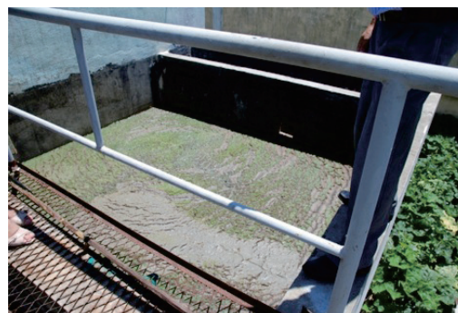
図 2.57 汚泥貯留槽
