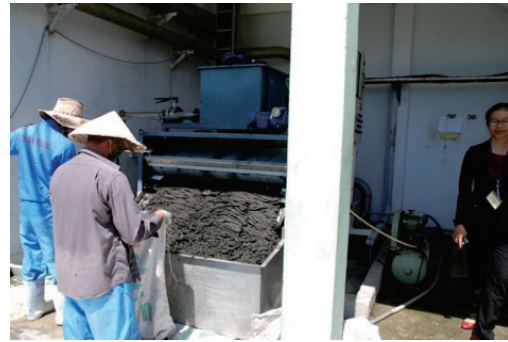
図 2.51 ベルトプレス脱水機
