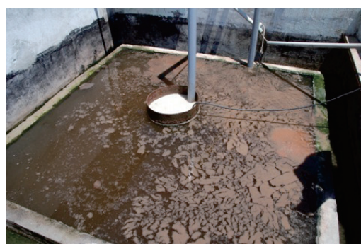
図 2.56 沈殿槽
