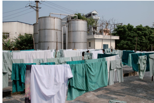
図 2.69 廃水処理施設
