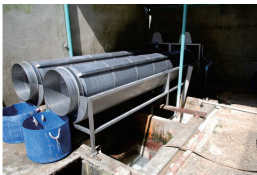
図 2.40 原水入口のスクリーン
