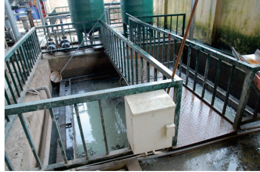
図 2.31 沈殿槽の状況
