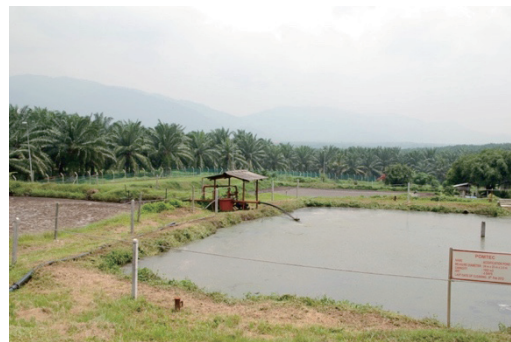
図 2.93 廃水処理施設（ラグーン）
