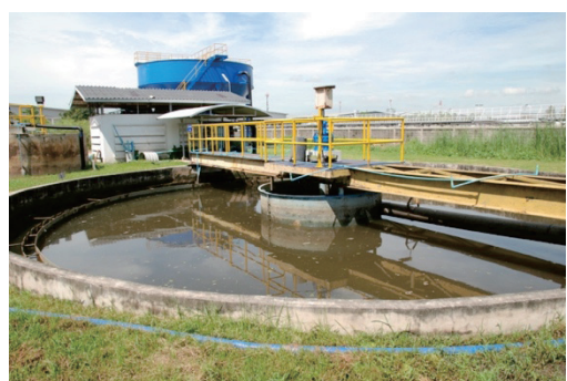
図 2.82 沈殿槽
