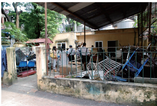
図 2.64 Viet Duc 大学病院の 廃水処理施設
