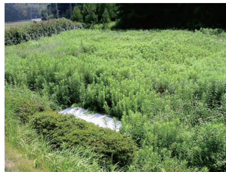
図 3.8 急速ろ過法（日本） 農村集落排水の高度処理
