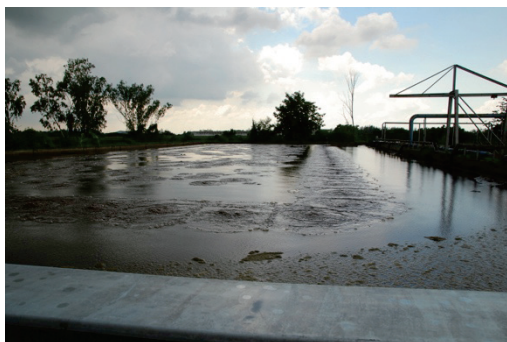
図 2.86 活性汚泥法の曝気槽
