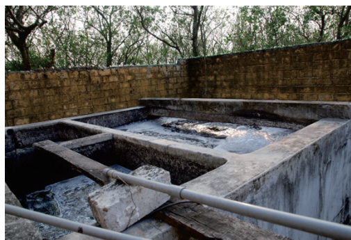
図 2.33 生物曝気槽
