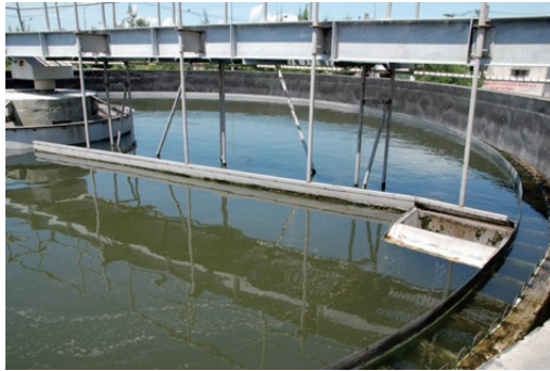
図 2.50 沈殿槽
