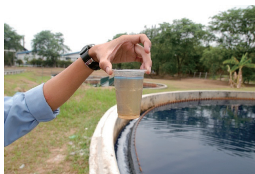
図 2.97 沈殿池 (手元が処理水、分離する上澄みあり)
