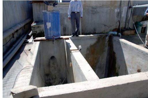
図 2.43 pH 調整槽
