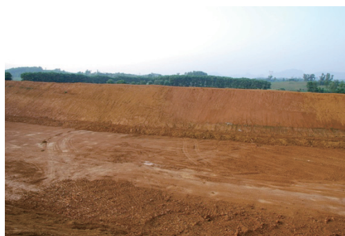
図 2.23 新規嫌気性ラグーン建設現場
