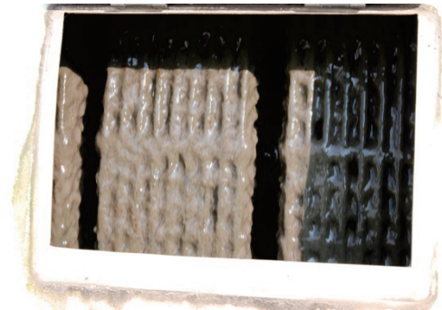
図 5.36 回転体に付着した生物膜
