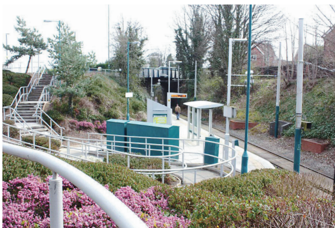
写真-3 軌道を下げ植栽した地域の停留所
