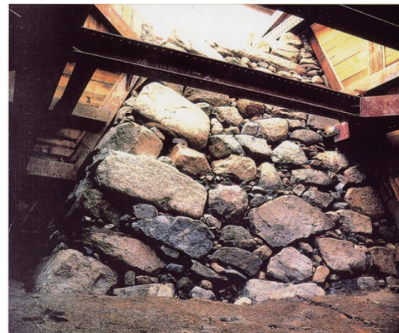
豊臣期石垣: 詰ノ丸石垣天正11年(1583) (写真提供: 大阪市文化財協会)
