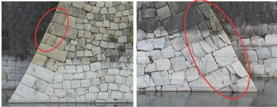
単純なクラック例（南外堀本丸側六番櫓下） 複雑なクラック例（南外堀本丸側四番櫓下）
