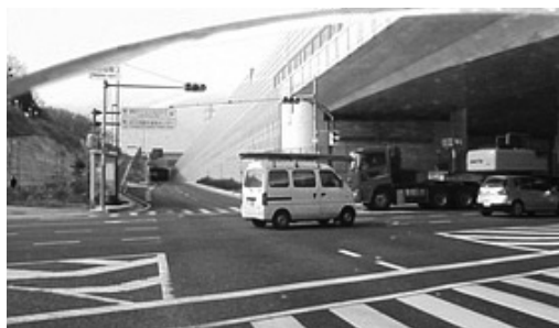
図3 国道307号線の交差点
