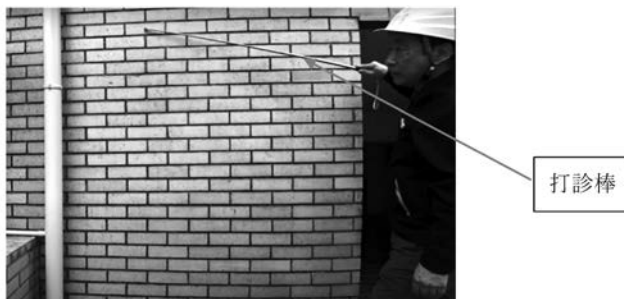
図3 打診棒によるタイル外壁の診断風景 (2)
